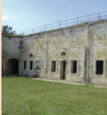
Casemates du fort Liédot - © Debeve2001-Fotolia
