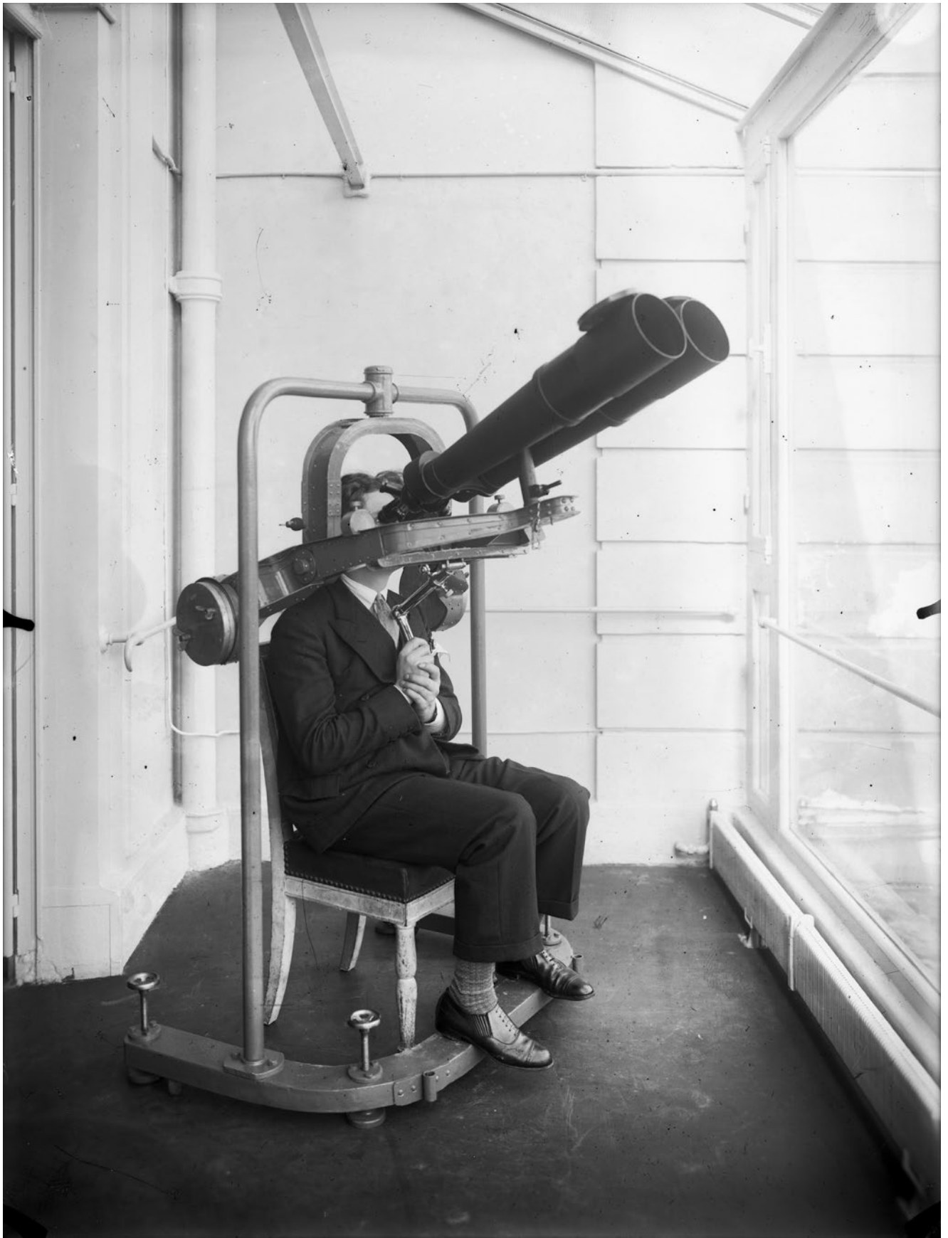
Jumelles de très longue portée (octobre 1930). Le poids des jumelles, de même que la nécessité d'obtenir une image stable et précise, ont conduit les inventeurs de Meudon à les monter sur un dispositif adapté à un véhicule de transport militaire.
